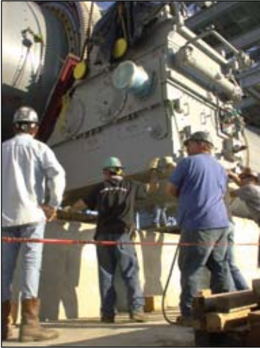
Рис. 8. Монтаж первого LGD в Мехико, 2003 г.
